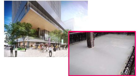
新本社ビルの耐圧スラブへの「スラグリート®70」適用状況
