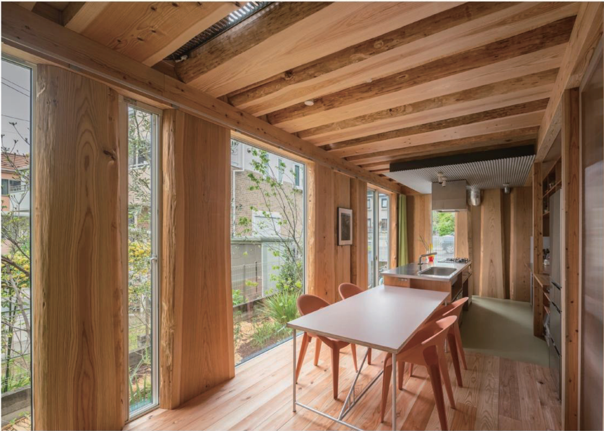
1階ダイニングキッチン。杉大径木の柱梁アラワシの空間。木材は熊本県の小国杉で、乾燥には地熱中温室を使用
