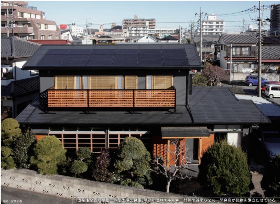
屋根一体型太陽光発電3.42kwゼロエネルギー計算削減率6.2%。開発窓が建物を際立たせている。
