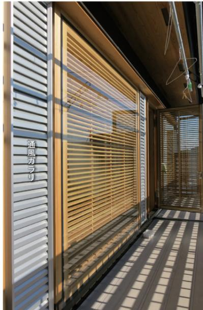
2階南のF1X窓は木枠の両面に5mmのガラスを接着するもので、中に木製ガラリを挿入してプライバシーを確保する日射遮蔽を実現。脇に断熱、通風戸をおいて夏は不在時に通風ができ、冬は閉めて断熱する。
