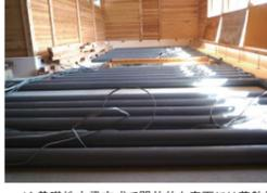
ベタ基礎地中梁方式で開放的な床下には蓄熱用の雨水入りパイプが並び、延長130m総量1m3超の水は大地上の熱移動を仲介する。水温は年間18℃から29℃を移ろうが、その様は悠然として「海」を思わせる。
