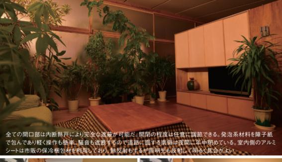
全ての開口部は内断熱戸により完全な遮断が可能だ。開閉の程度は任意に調節できる。発泡系材料を障子紙で包んであり軽く操作も簡単。騒音も遮断するので道路に面する南側は夜間に半閉鎖している。室内側のアルミシートは市販の保冷箱包材を利用しており、熱反射もするが照明光も反射して明るく真昼がよい
