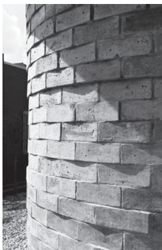
写真2 土ブロック外壁
