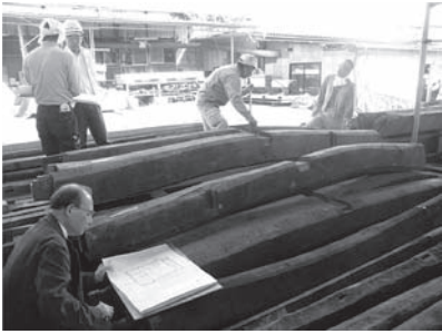
＜古材の検査と選定＞ 解体された古材を検査し選定
