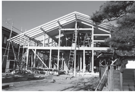
＜上棟＞ 検査した新材古材が組み上がる
