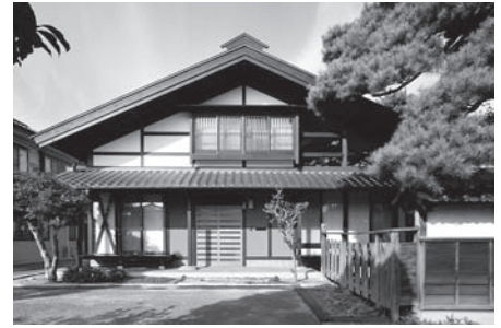
＜完成＞ 古材を使って新築された「本棟づくり」
