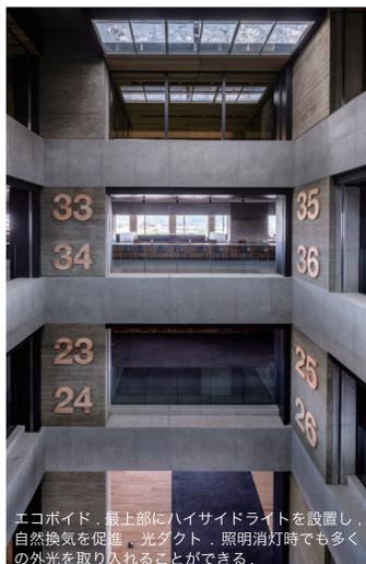
エコポイド。最上部にハイサイドライトを設置し、自然換気を促進、光ダクト。照明消灯時でも多くの外光を取り入れることができる。
