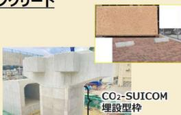
約150kg-CO<sub>2</sub>/コンクリートm<sup>3</sup> (埋設型枠)
