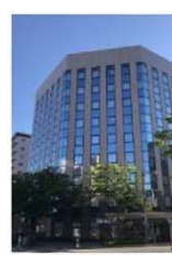
大同生命新澁ビル
