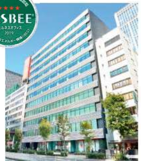
ヒューリック虎ノ門ビル
