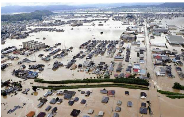
外水氾濫の例 2018年7月（岡山県 真備町）
