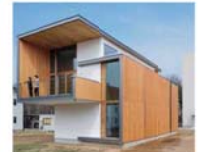
CLT工法による実験棟
