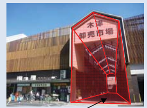
常時外気に開放された部分
