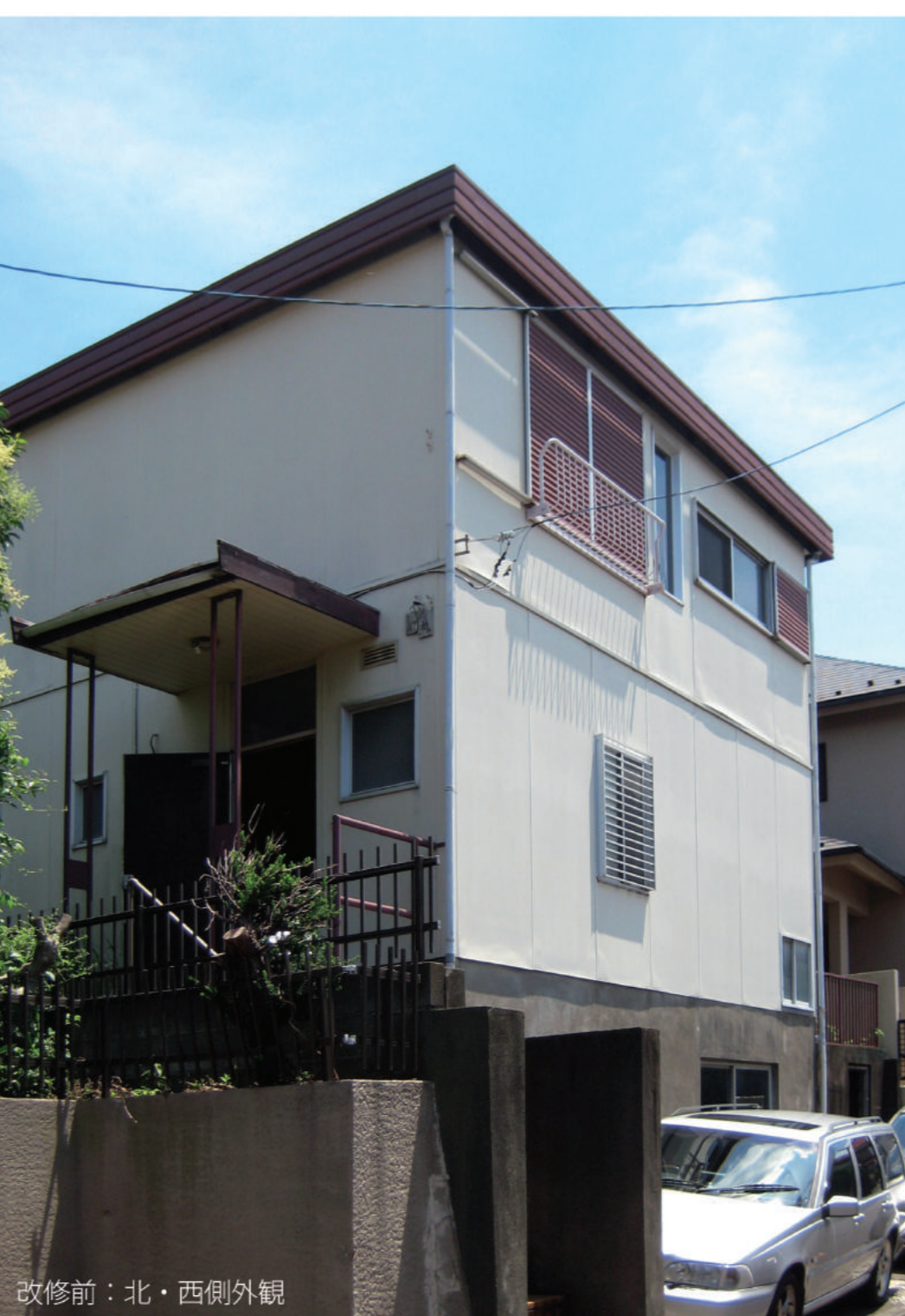
改修前：北・西側外観
