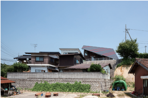
遠景【西側から見る】強い西日を遮りつつ、冬の直射日光が室内に届くよう大屋根の角度を調整した
