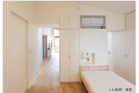
■通風と採光のための開口部の配置 各居室にはできるだけ異なる壁面に2か所開口部を設け、通風促進と昼光利用に心がけた。敷地手前の平屋は、奥に長いワンルールの構成で、室内に光が届くようにハイサイドライトやトップライトを採用し、全体的な明るさを確保した。2軒とも浴室や洗面などの水まわりには防犯に配慮した小さな開口部を設け、夜間でも自然換気ができるようになっている。
