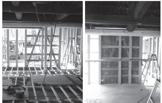
写真15 耐力壁（筋交い、土壁）
