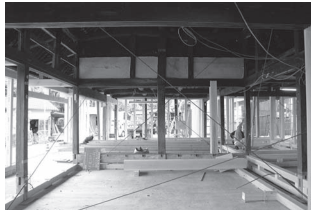
写真6 土間コン打設/足固め
