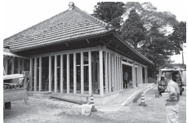
写真17 柱を新設
