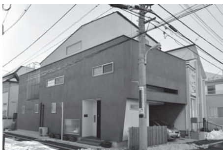
北東面の外観
