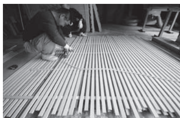
写真9 木小舞パネル製作
