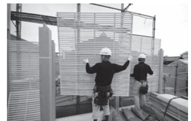
写真10 木小舞パネル落とし込み
