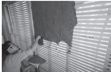
写真8 木小舞片面土塗り
