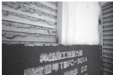
写真6 片面土塗りと断熱、面材の構成
