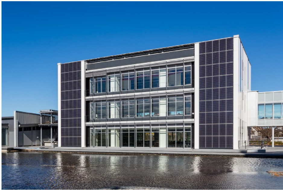
エクスチェンジ棟 外観 (南面)
