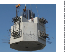
20トンの基礎PCaを積重
