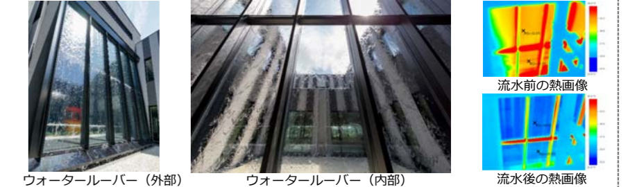
■ウォータールーバー (外部) ウォータールーバー (内部) 流水前の熱画像
